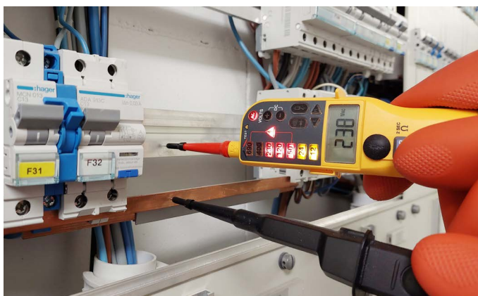
Figura 11: verifica dell'assenza di tensione (fonte Electrosuisse)
