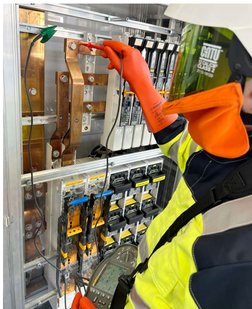
Figura 12: misura della corrente di cortocircuito (fonte Electrosuisse)
