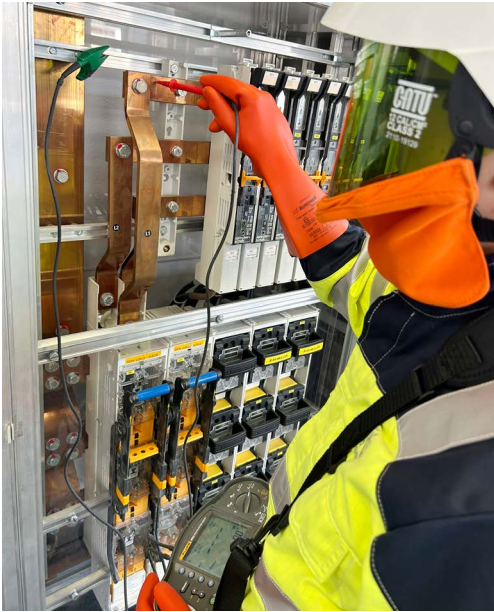
Bild 12: Messen des Kurzschlussstromes (Quelle Electrosuisse)
